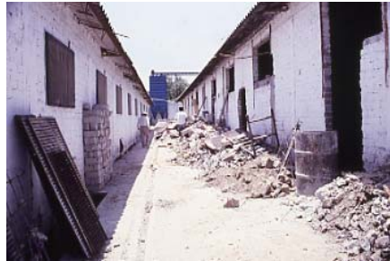
Abriendo ventanas para corregir ventilación.
